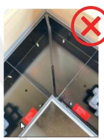
Bei Gehrungsecken wird eine Überlänge des Rahmenprofils werkseitig vorgesehen. Damit kann bei Montagearbeiten eine allfällige bauliche Ungenauigkeit sauber ausgeglichen werden (kürzen des Rahmens). Trotz allem kann ein Spaltmass entstehen, jenes sollte mit Isolation abgeklebt werden.
