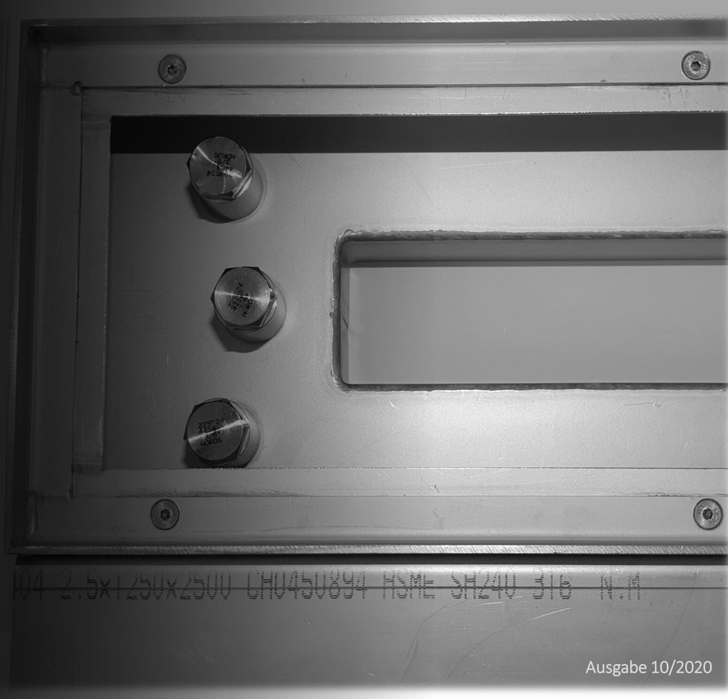
1. Bord de cadre 3mm parfaitement vissé sur le caniveau (vis noyées)
