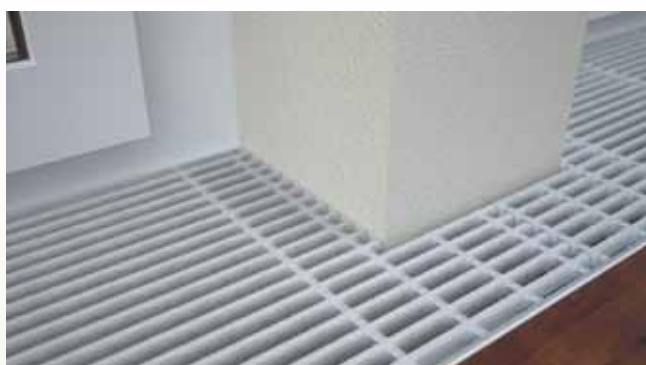
Découpe rectangulaire de grille enserrant un pilier
