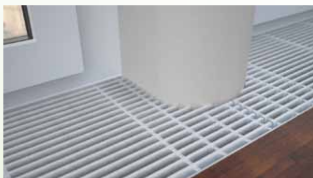
Découpe circulaire de grille enserrant un pilier
