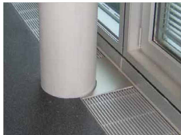
EINBAU MIT BLINDBLECH UND SÄULENAUSSCHNITT
